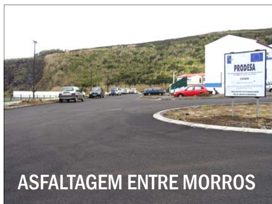
ASFALTAGEM ENTRE MORROS
