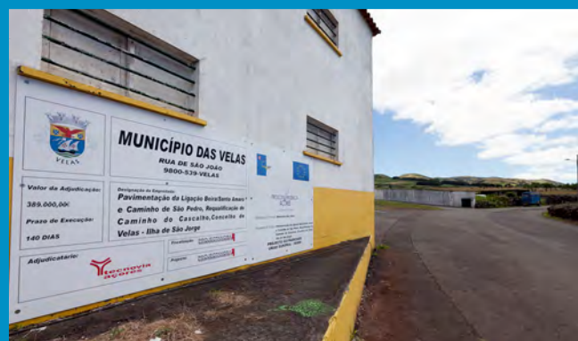
Pavimentação do Caminho Beira-Santo Amaro
