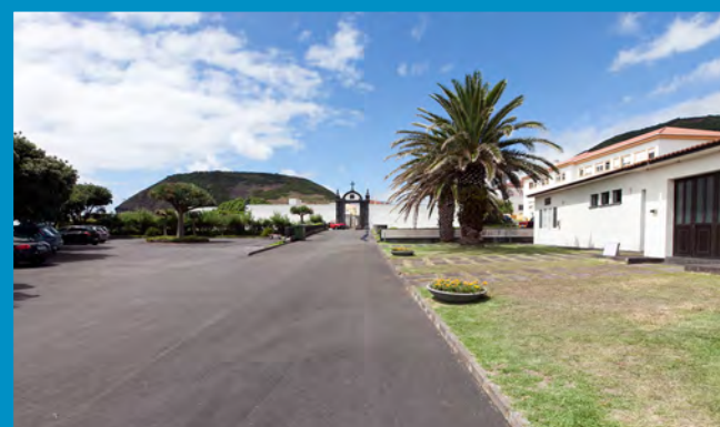
Pavimentação do Caminho do Cemitério
