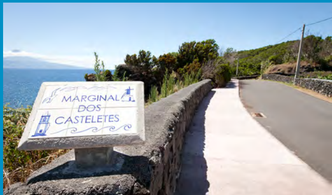
Construção de passeios na Marginal dos Casteletes
