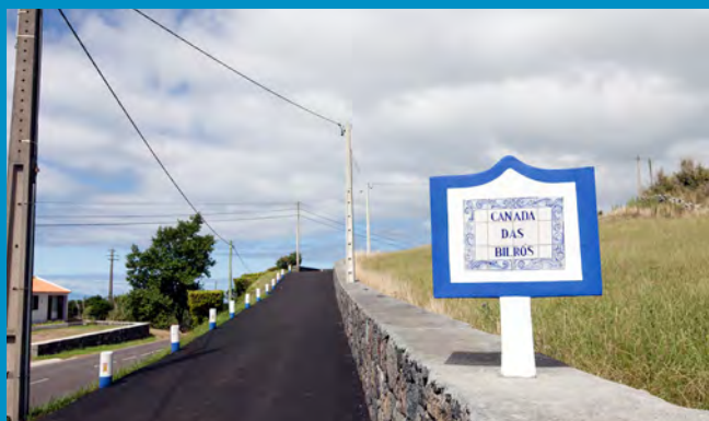
Pavimentação da Canadas das Bilrós
