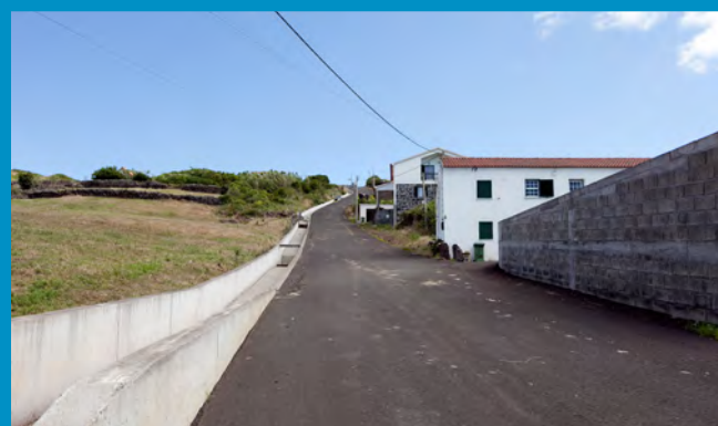
Pavimentação do Caminho da Serroa
