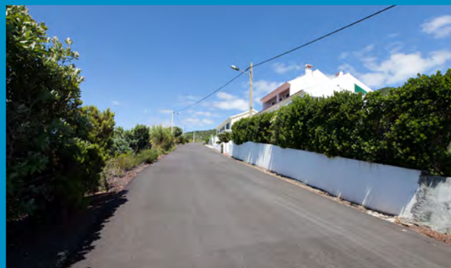
Pavimentação do Caminho dos Portinhos
