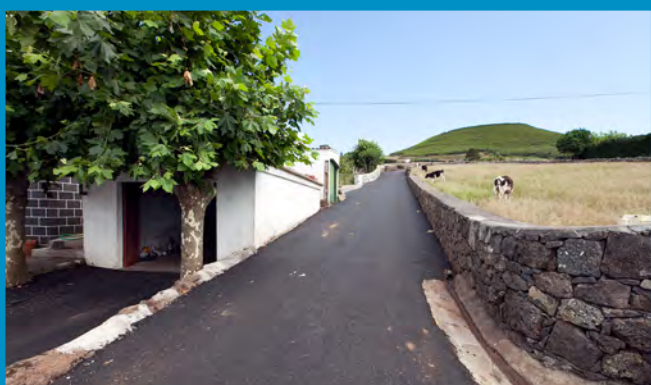
Pavimentação da Canada do Cunha
