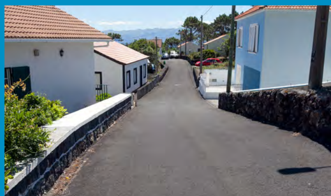
Pavimentação da Canada do Mistério (Urzelina)
