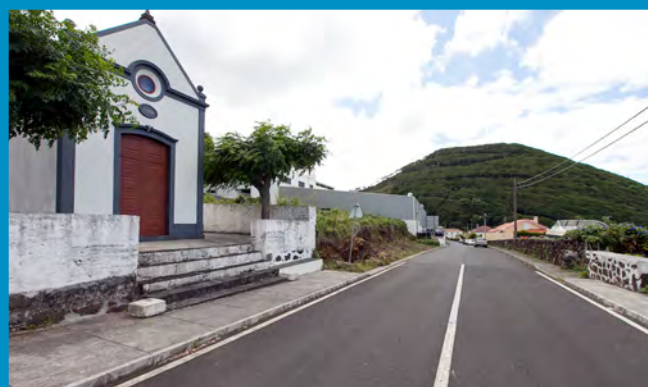
Pavimentação do Caminho de São Pedro
