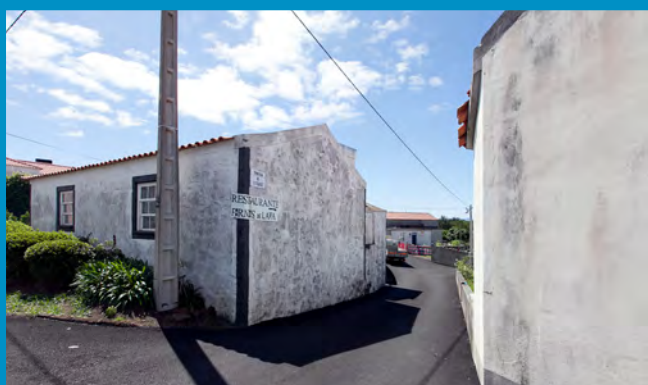
Pavimentação da Travessa de Santiago
