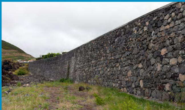
Capeamento do Muro na Avenida da Conceição
