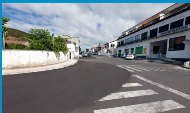
Alargamento do Cruzamento da Av. do Livramento
