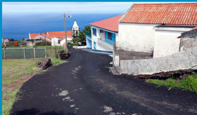
Pavimentação da Canada dos Fragas
