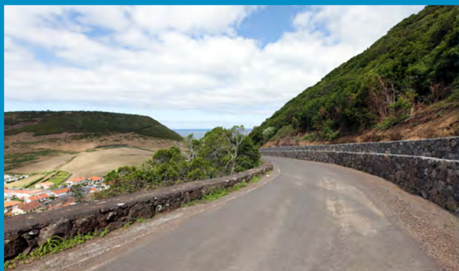
Construção de Muros no Caminho dos Cavalos
