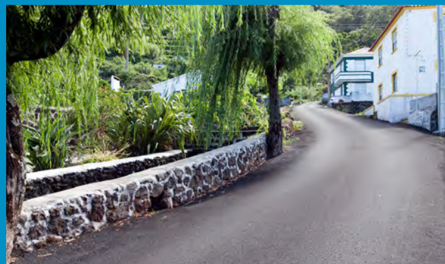
Pavimentação do Caminho Velho (Norte Grande)
