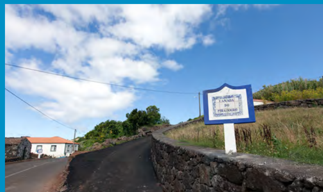
Pavimentação da Canada do Miradouro
