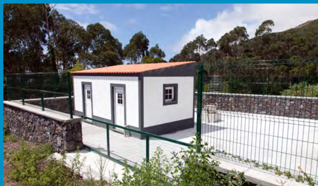
Reabilitação da Rede de Água
