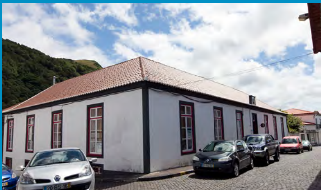
Substituição do teto dos Paços do Concelho
