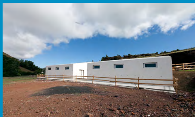
Construção do wc's para o XIII Jamboree Açoriano
