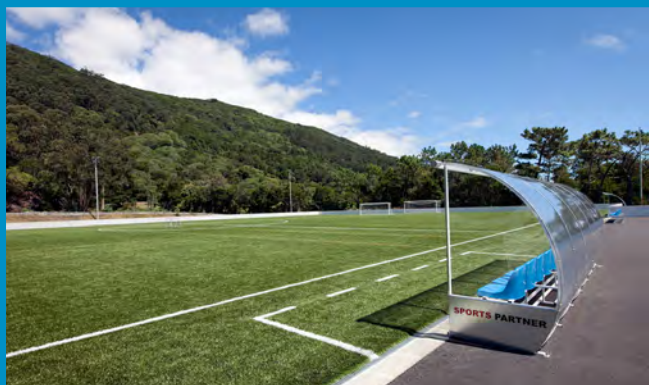
Construção do Campo de Jogos da Urzelina
