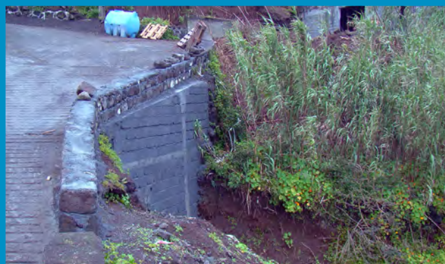
Reparação de muros no Caminho dos Degraus
