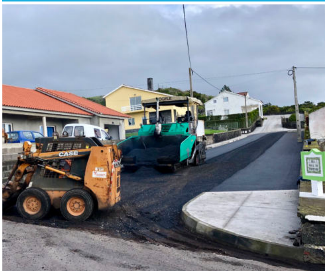
Pavimentação da Rua Nova do Portinho, no lugar da Fajã de Santo Amaro
