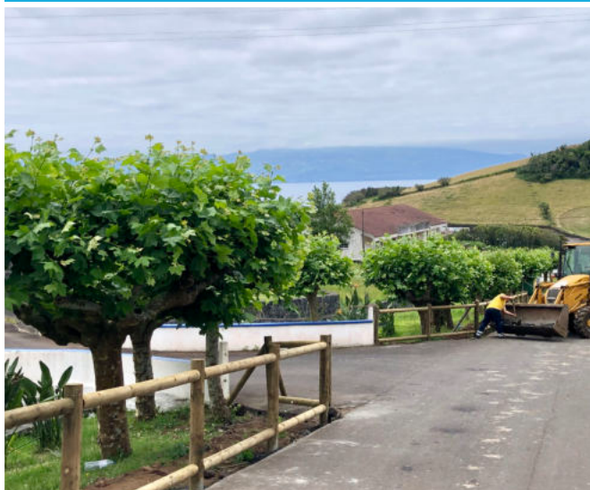
Colocação de nova vedação em Madeira tratada no lugar da Ribeira de Água, em articulação com a Junta de Freguesia dos Rosais
