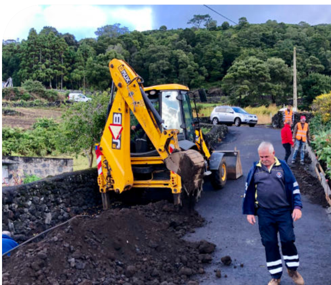
Reparação e nova conduta de água na Canada da Encarnação na Ribeira do Nabo, Freguesia da Urzelina
