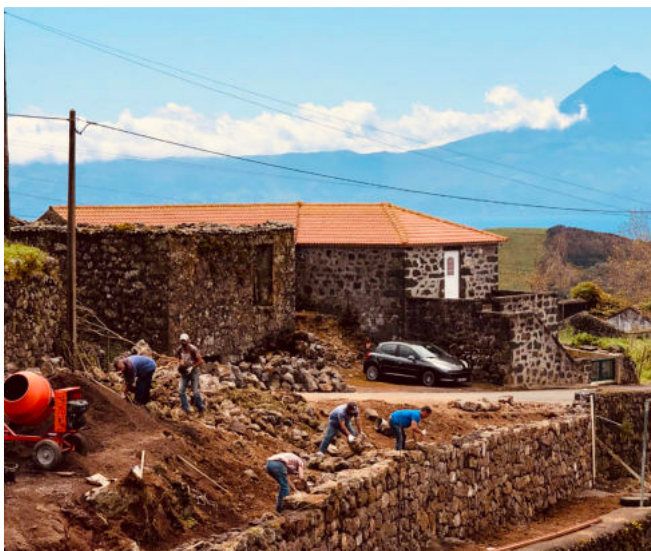
Correção e construção de paredes no Caminho Velho na Beira em parceria com a Junta de Freguesia de Velas
