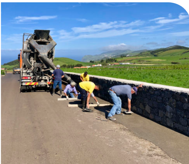
Construção de paredes e valetas na Rua das Macelas em Santo Amaro, em colaboração com a Junta de Freguesia
