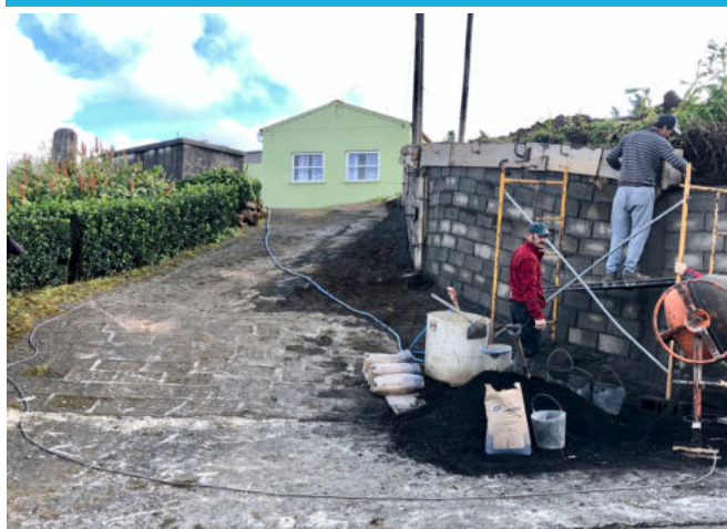
Obra de melhoramento de acesso a viaturas de socorro em Santo António, Freguesia do Norte Grande
