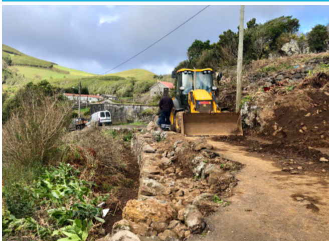
Obra de acesso a viaturas de socorro em Vias Municipais, em articulação com a Junta de Freguesia dos Rosais
