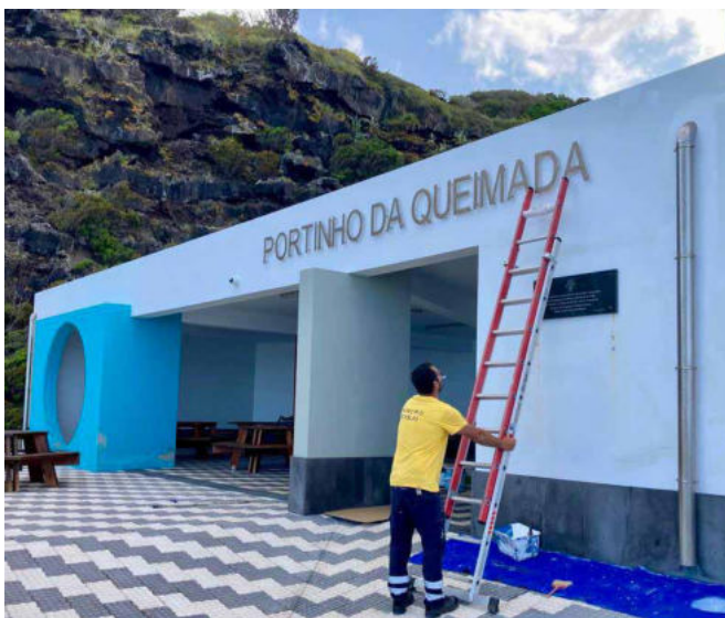
Manutenção e conservação do Edifício de apoio à Zona de Banhos no lugar dos Portinhos da Queimada.
