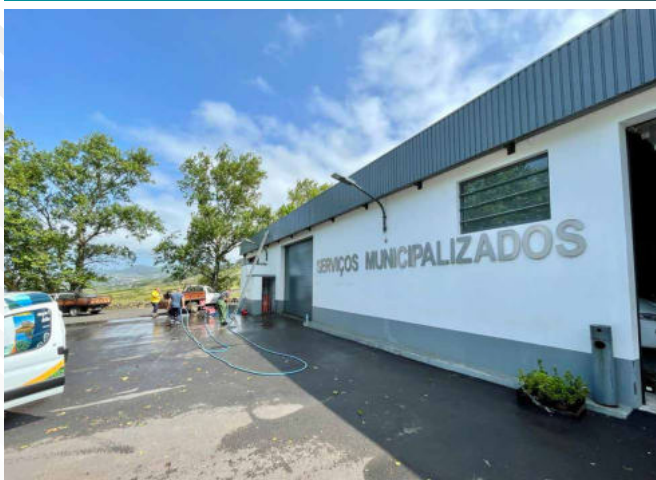
Manutenção/ pintura do Edifício onde funcionam os Serviços Municipalizados.
