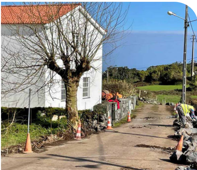
Melhoramento do caminho de acesso à Casa do Espírito Santo da Ribeira da Areia.
