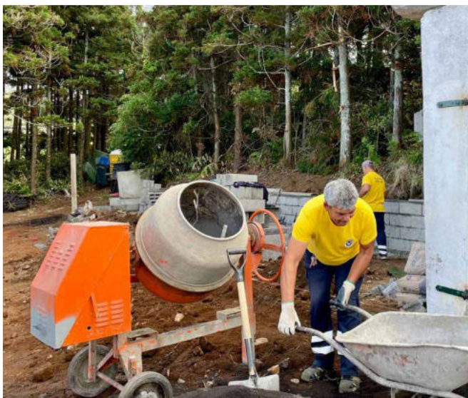
Preparativos com vista à construção de um novo Armazém, onde funcionam os Serviços Municipalizados.
