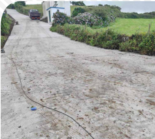
Pavimentação de parte de um Caminho de Aptidão Agrícola no Lugar da Ribeira da Areia.
