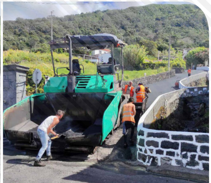
Trabalhos na Canada da Ribeira no lugar dos Terreiros, Freguesia de Manadas.
