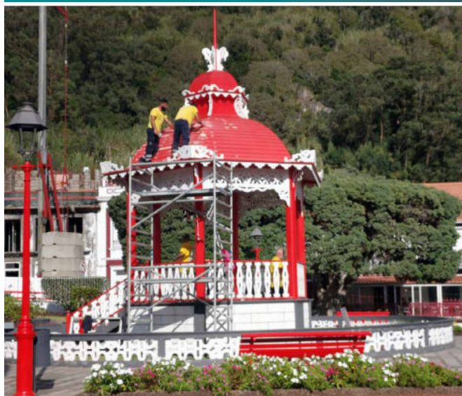
Manutenção e pintura do Coreto do Jardim da República.
