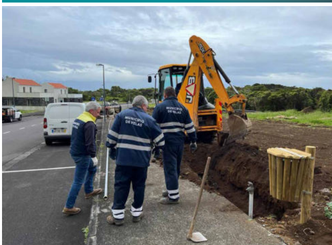
Abertura de um novo ramal de abastecimento de água na Zona dos Casteletes, na Freguesia da Urzelina.
