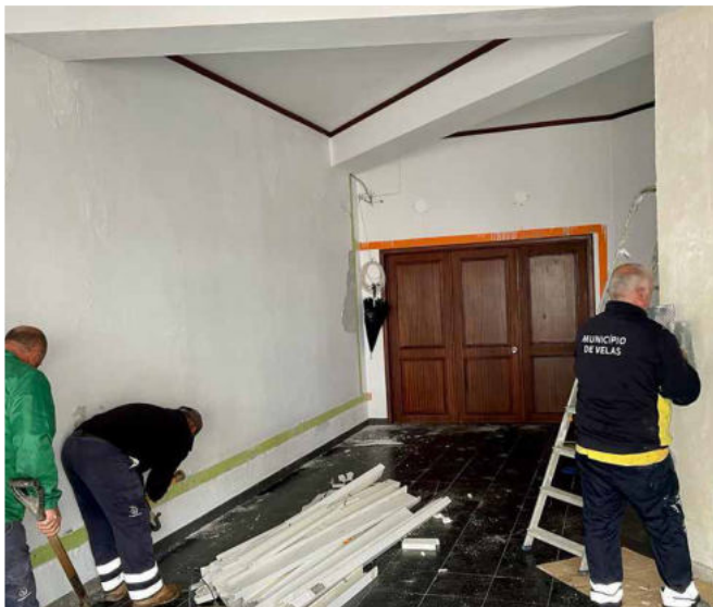
Reabilitação da Galeria Espaço+, sita no Auditório Municipal de Velas.
