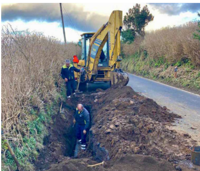
Reparação de um derrame na principal conduta de abastecimento público de água à População.
