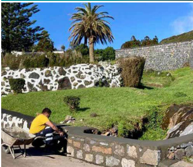
Reparações nas Linhas de Água (Grotas e Ribeiras).
