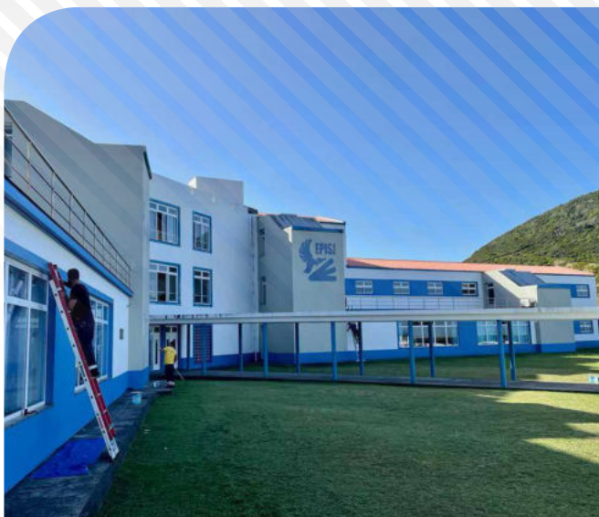
Obras de manutenção e conservação do edifício da Escola Profissional da Ilha de São Jorge.
