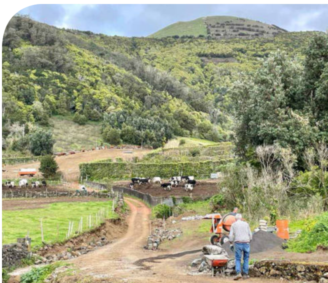
Obras de melhoria na Zona do Desterro, em parceria com a Junta de Freguesia de Santo Amaro.
