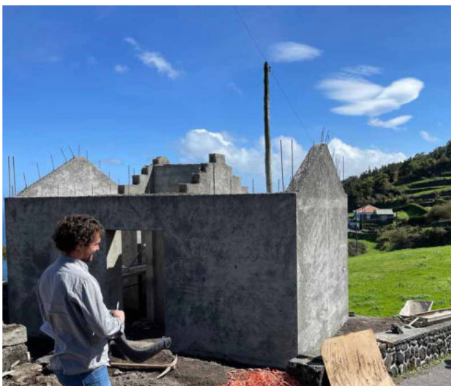
Construção de Instalações Sanitárias no Miradouro da Fajã do Ouvidor.
