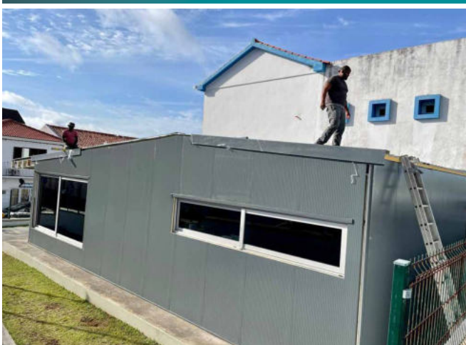
Obras de Reabilitação no Edifício Municipal, onde funciona a Escola Primária de Velas.
