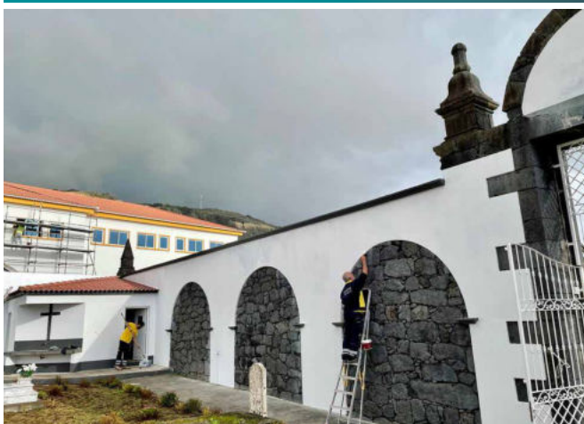
Pintura e manutenção do Cemitério das Velas.
