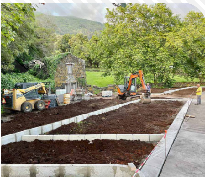
Obras de Reabilitação de troço da antiga Estrada Regional no Lugar da Boa Hora.
