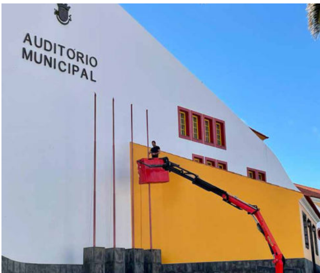
Manutenção do Edifício do Auditório Municipal das Velas.
