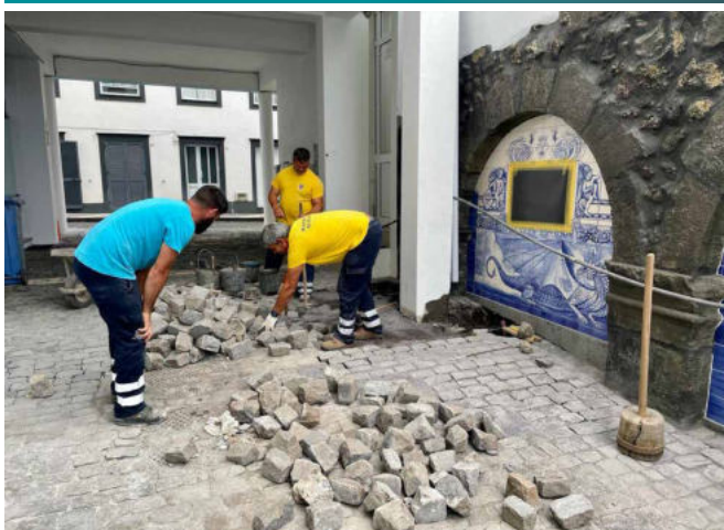
Reparação da calçada nas ruas do Centro Histórico da Vila.
