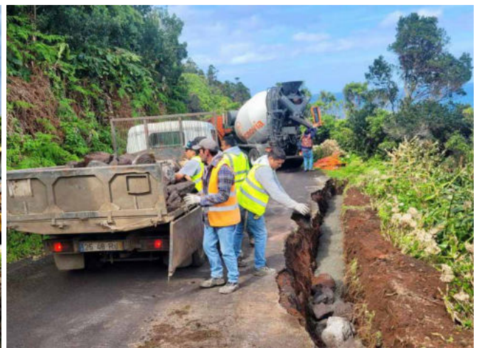
Correções na Via Municipal de acesso à Fajã da Ribeira da Areia.
