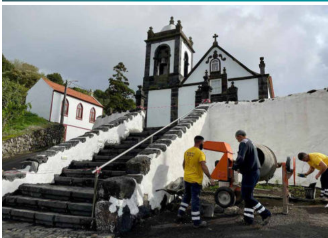
Recuperação e manutenção da escadaria central do exterior da Igreja de Santa Bárbara.
