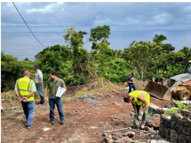
Obras de melhoramento nas vias da responsabilidade do Município na Fajã do Ouvidor.
