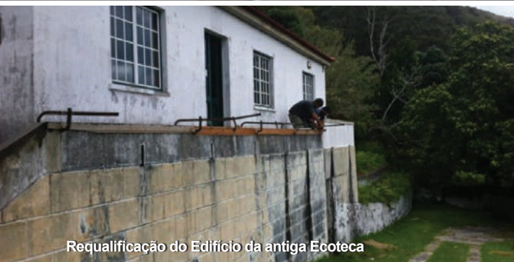
Construção de caixas de escoamento de águas pluviais
