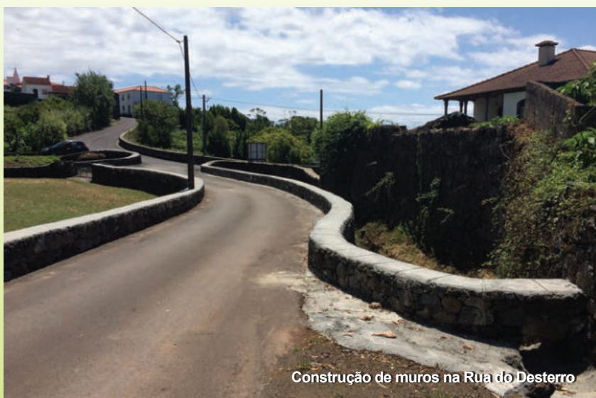
Obras de beneficiação no Porto do Carregadouro e área envolvente
