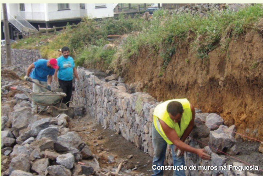
Reconstrução e Recuperação das casas da Junta
