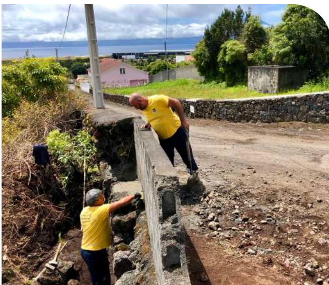
Construção de Poço Sumidouro por forma a melhorar a drenagem das Águas Pluviais nas Vias Municipais
