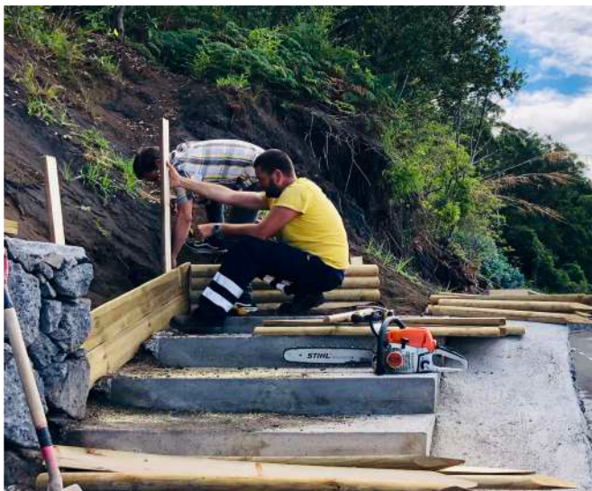
Construção de uma escada em Madeira Tratada
