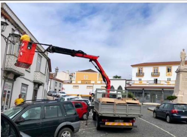
Colocação de novo sistema de Iluminação Pública em LED na denominada Praça Velha
