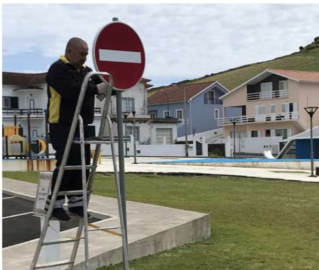
Manutenção e conservação da Sinalização de Trânsito na Zona de Entre Morros
