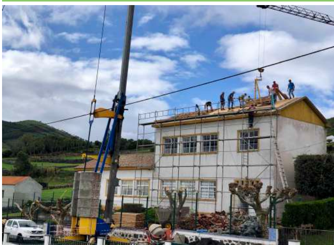
Obras de conservação no Edifício da antiga Escola Primária dos Rosais
