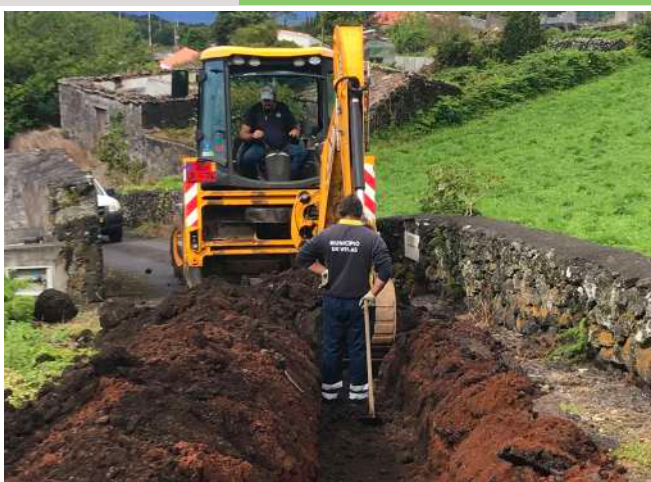
Reabilitação da Condução de Água na Canada do Leitão, na Ribeira do Nabo
