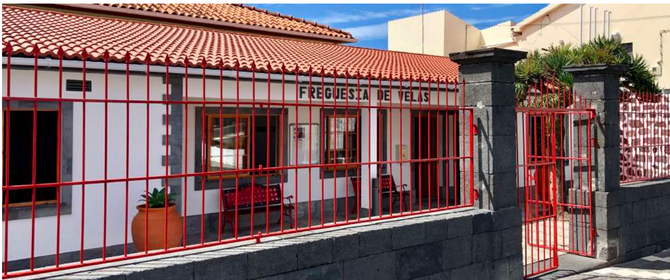
Apoio nas obras de reabilitação do Edifício Sede da Junta de Freguesia de Velas
