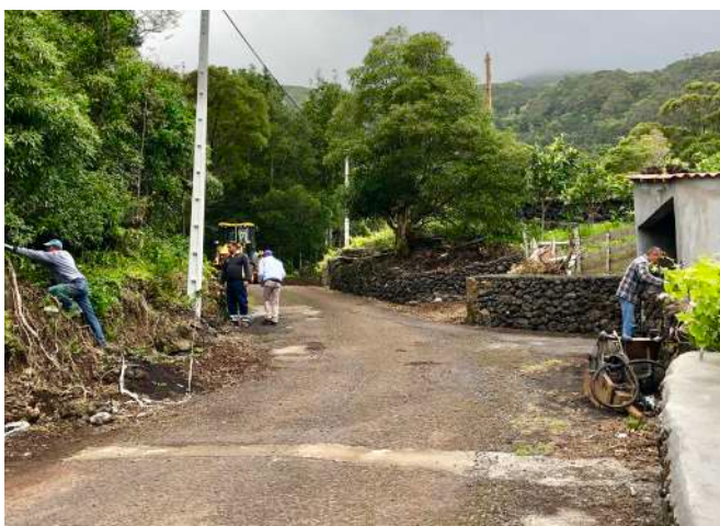
Recuperação e requalificação dos muros de suporte e proteção da Canada da Bica, em parceria com a Junta de Freguesia da Urzelina
