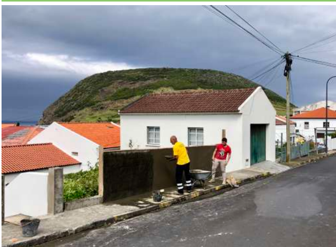
Trabalho de conservação e melhoramento dos espaços públicos Municipais
