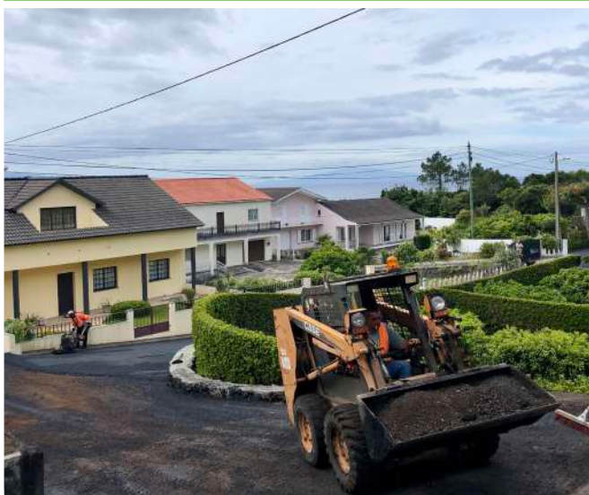
Repavimentação do arruamento da Rua da Boa-hora no lugar da Queimada
