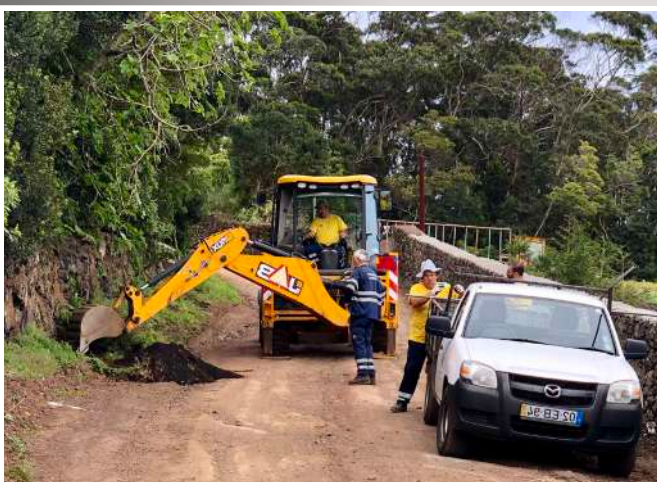
Colocação de Ramais para Abastecimento de Água à População no Caminho das Areias
