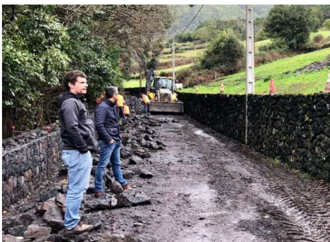
Reabilitação do Caminho de Cima na Ribeira do Nabo
