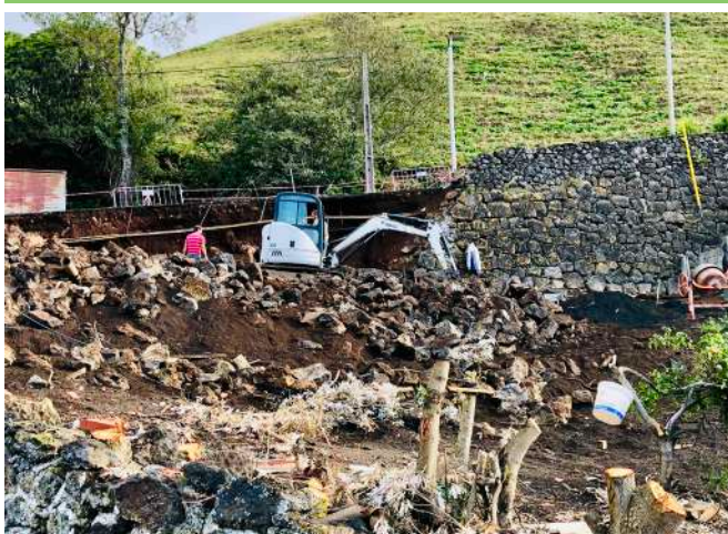
Reparação de muro na zona da Piedade em Velas
