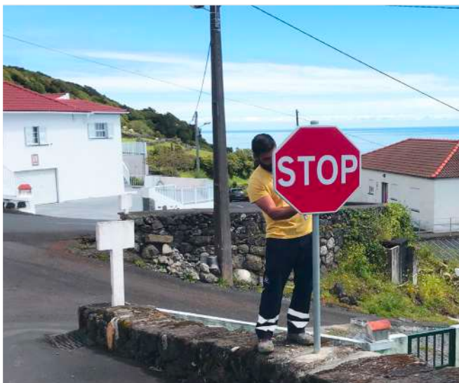
Colocação de Sinalização de Trânsito, nas Canadas e Caminhos Municipais, na Freguesia das Manadas
