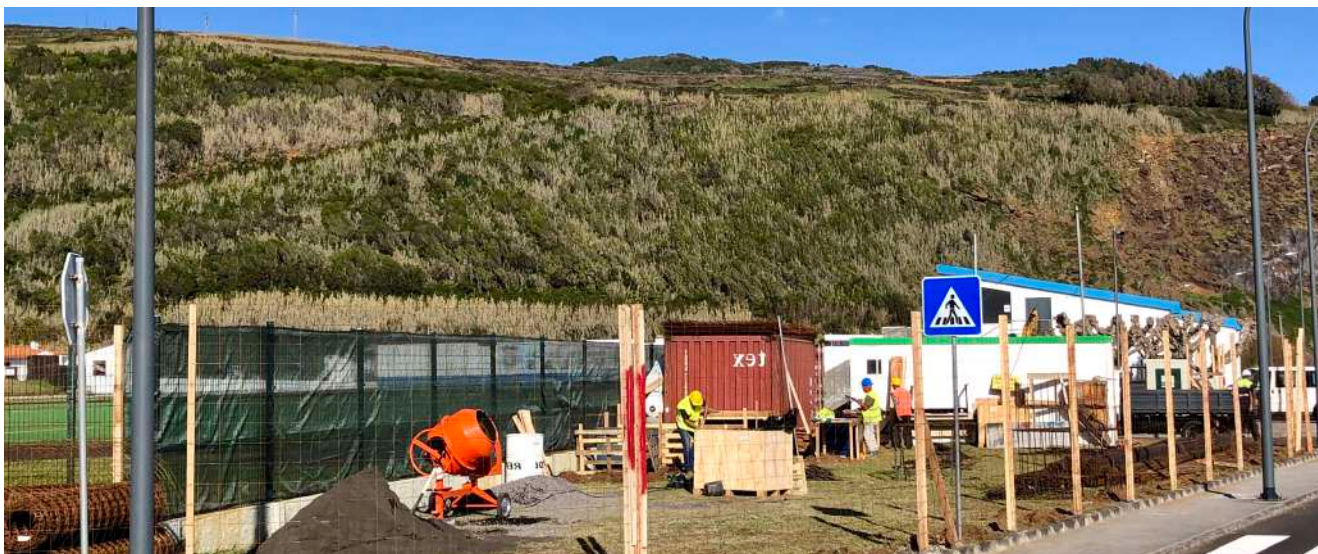
Construção da cobertura das bancadas no Campo Municipal de Velas
