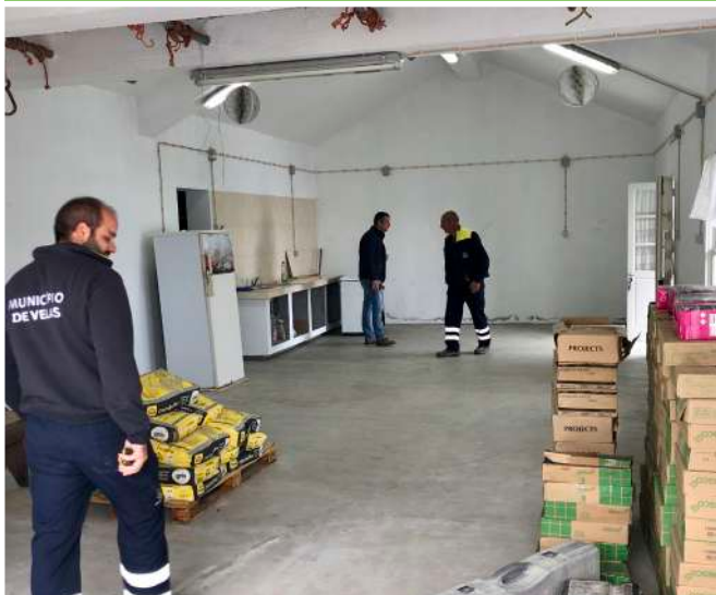
Obras de conclusão da Casa dos Mancebos, sita na Fajã do Ouvidor/ Norte Grande, em parceria com a Junta de Freguesia
