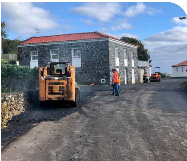
Reparação de bermas e sobras de estrada na Ribeira do Nabo
