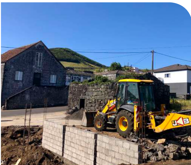
Construção de parede em Ribeira no Lugar da Beira
