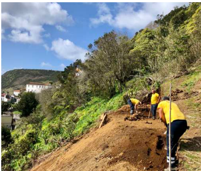
Trabalhos de preparação para colocação da imagem de marca do Concelho "Velas, Capital do Queijo"
