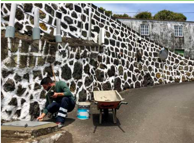
Reparação e conservação das infraestruturas da Rede de Distribuição de Água à População
