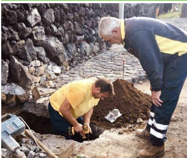
Colocação de novas Bocas de Incêndio na Fajã das Almas
