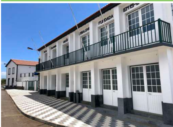
Colocação de Calçada 2000, em sobre de estrada Regional, em frente à Sede da Sociedade Filarmónica União Rosalense, em articulação com a SRTOP e Junta de Freguesia
