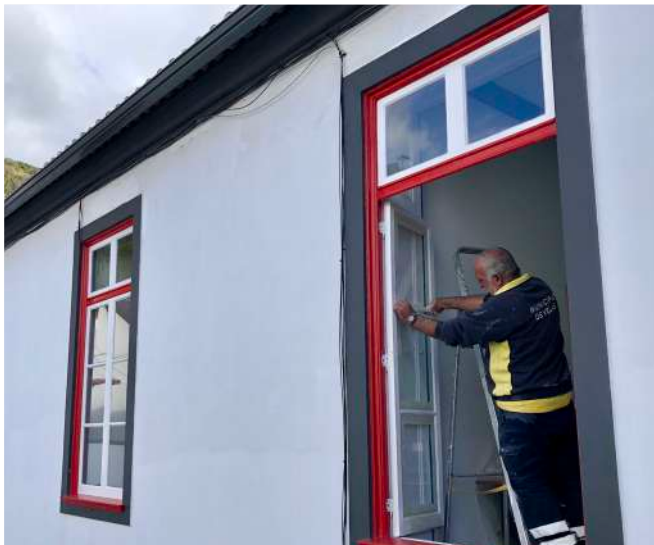
Manutenção de Portas e Janelas do Edifício dos Paços do Concelho
