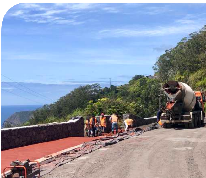
Construção de Miradouro no Caminho das Areias
