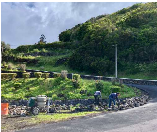
Construção de paredes na zona do Rubineu, em colaboração com a Junta de Freguesia de Sto. Amaro
