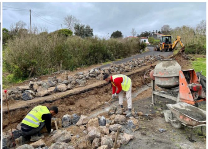
Construção de paredes de consolidação e proteção do caminho no Lugar de São Pedro.
