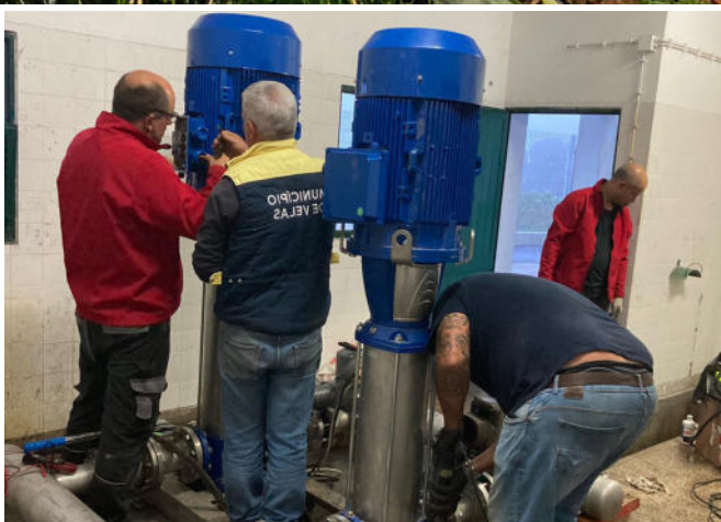
Montagem de um novo sistema de bombas de água para abastecimento público.
