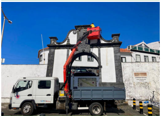
Limpeza e pintura do Arco do Cais primitivo de Velas.
