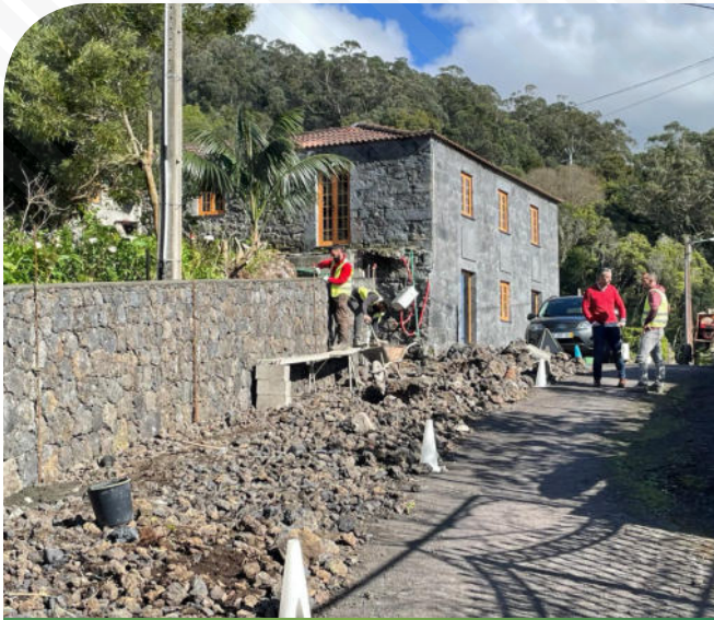
Trabalhos de recuperação de um troço de parede no Caminho do Extremo, em articulação com a Junta de Freguesia da Urzelina.
