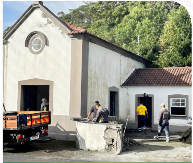
Recuperação da Ermida de Sta. Rita, em colaboração com a Comissão Fabriqueira da Igreja de Sta. Bárbara das Manadas.
