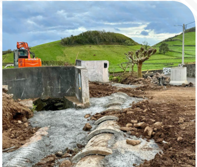
Melhoramento de passagem hidráulica na Ribeira de Água, em articulação com a Junta de Freguesia dos Rosais.
