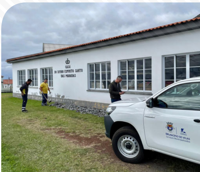
Obras de conservação e manutenção da Casa do Espírito Santo, em articulação com a Junta de Freguesia das Manadas.
