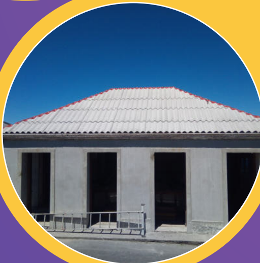
Fiscalização da Empreitada de Requalificação de Antiga mercearia
