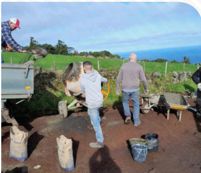
Intervenções de melhoria nos Caminhos de Aptidão Agrícola, em articulação com a Junta de Freguesia do Norte Grande.
