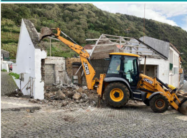
Colaboração com a Casa de Repouso João Inácio de Sousa na demolição das antigas garagens.
