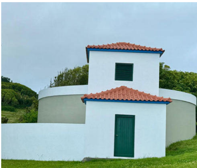
Pintura de reservatórios de água em vários locais e Freguesias do Concelho.
