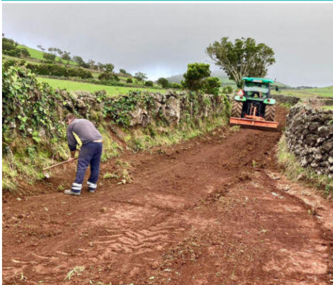
Trabalhos de manutenção e conservação dos Caminhos Agrícolas do Concelho.
