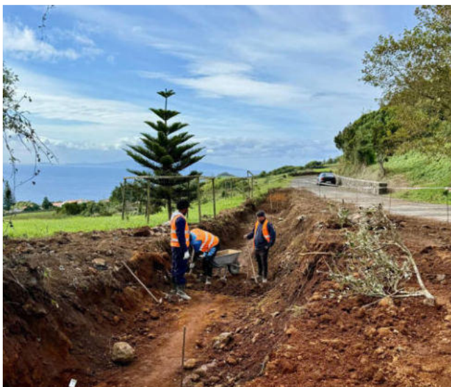
Construção de canal de drenagem de águas pluviais no lugar do Poço Novo, na Freguesia dos Rosais.
