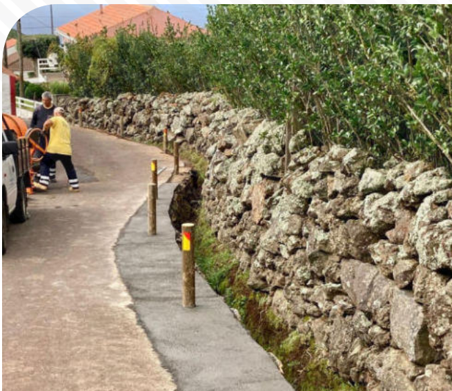
Reforço da parede de suporte da linha de água, em articulação com a Junta de Freguesia dos Rosais
