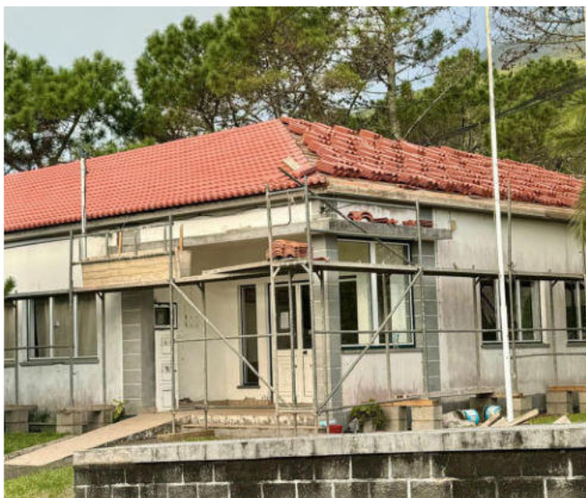
Obras de reabilitação do edifício da Casa do Povo da Urzelina.
