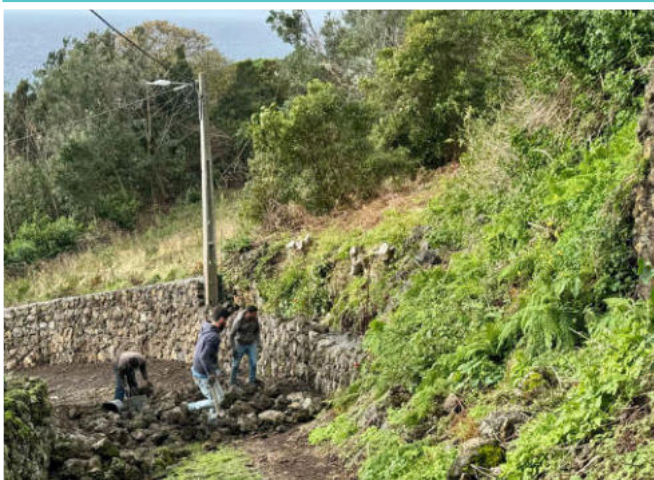
Reabilitação dos muros de suporte e proteção do Caminho da Igreja na Freguesia das Manadas.
