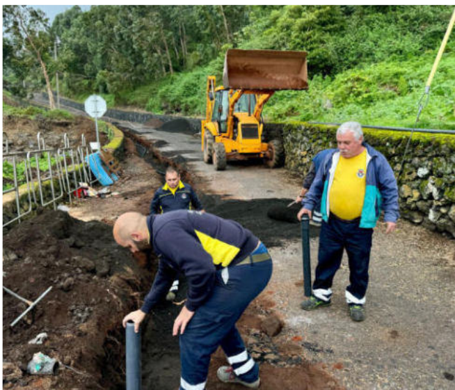
Construção de nova conduta de abastecimento público de água no lugar do Extremo.
