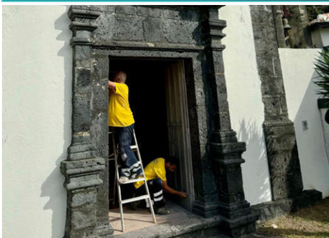
Reabilitação da porta da Ermida da Senhora da Boa-Morte, sita na Freguesia da Urzelina.
