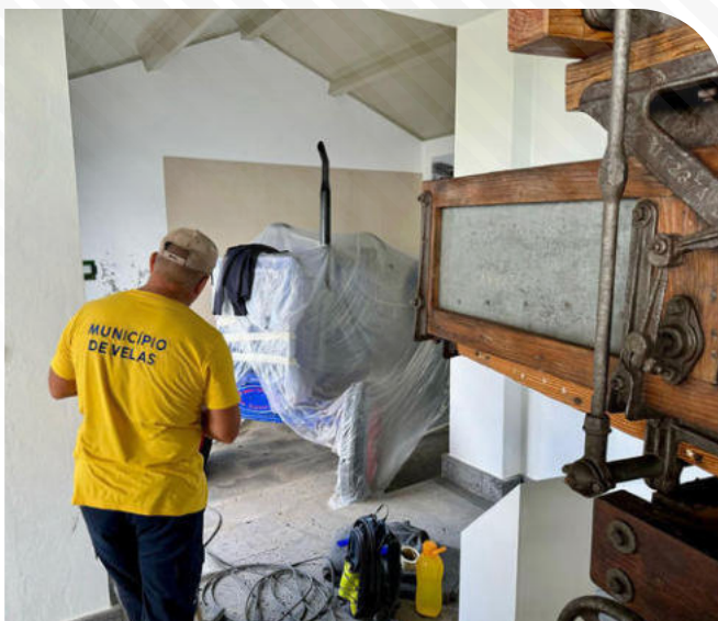
Conservação e manutenção do edifício do Núcleo Museológico denominado "Rosais, Celeiro da Ilha".
