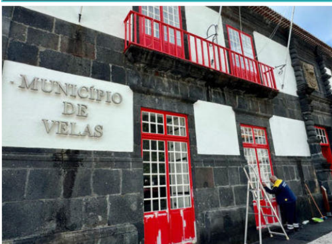
Manutenção do Edifício dos Paços do Concelho.
