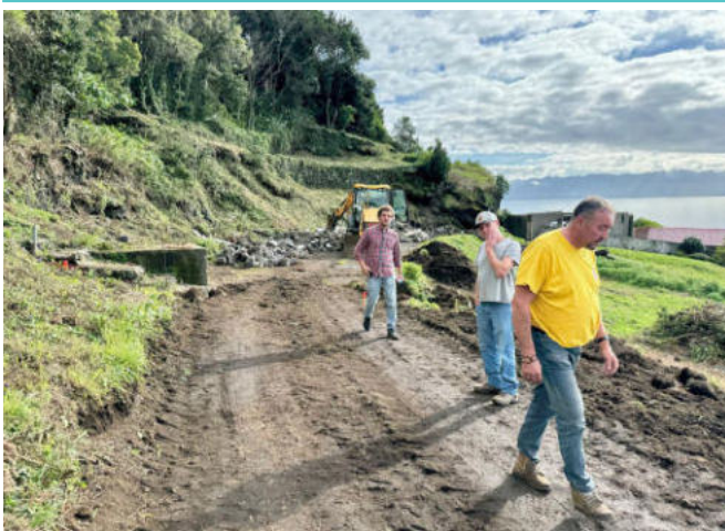
Melhoramentos na Canada do Leitão, sita na Ribeira do Nabo, Freguesia da Urzelina.
