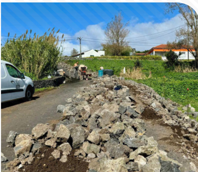
Reconstrução e construção de muros em pedra no Caminho Municipal no Lugar de São Pedro.
