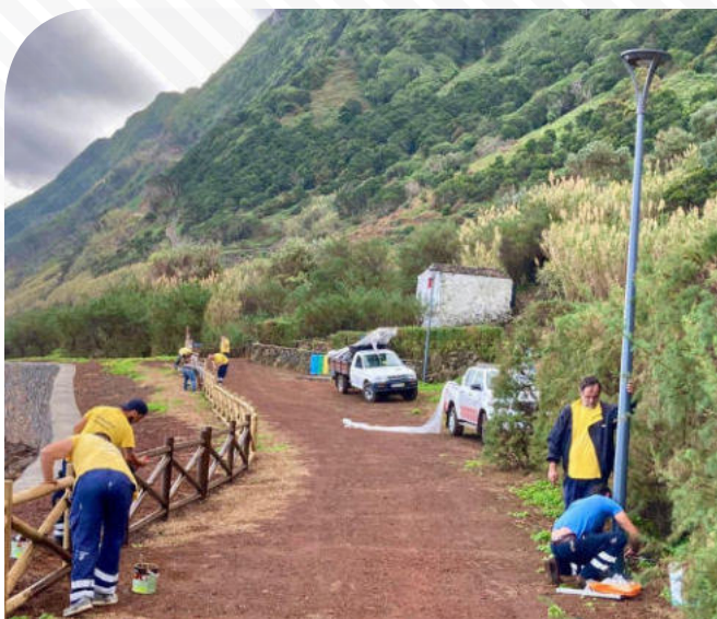
Colocação de colunas de iluminação em Led, com sistema solar, na Fajã da João Dias.
