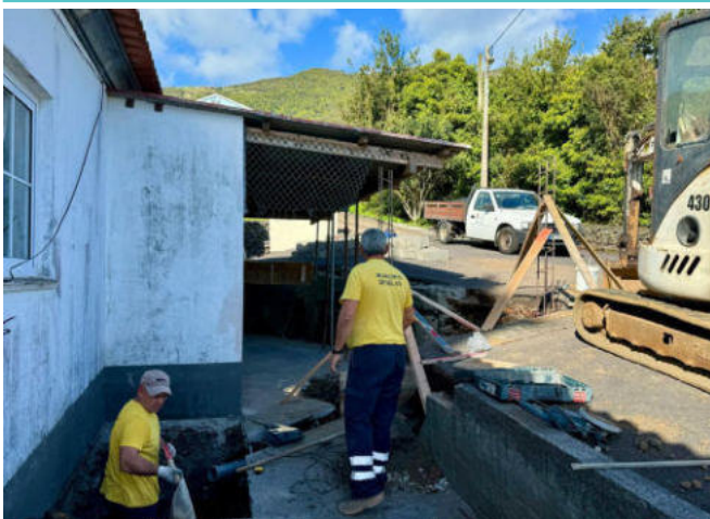
Obras de reabilitação da cozinha de apoio ao Salão Paroquial da Urzelina, em colaboração da Junta de Freguesia.
