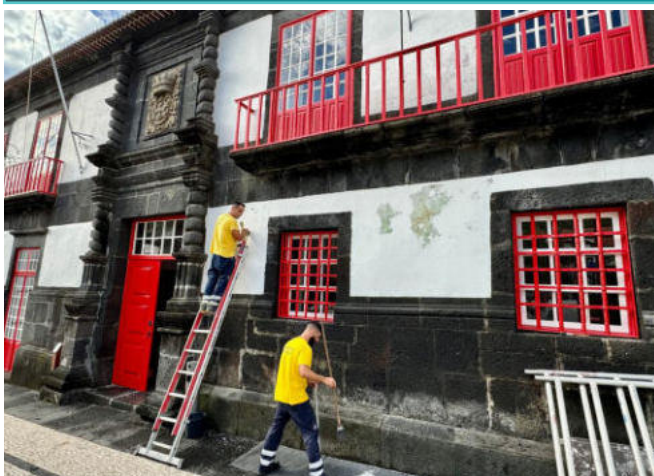
Obras de conservação no Edifício dos Paços do Concelho por via das equipas de pintura e pedreiros do Município.
