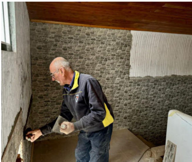
Obras de conservação e melhoramento das condições do edifício da Sociedade Filarmónica União Rosalense.
