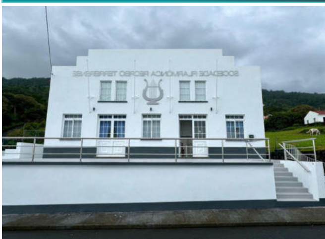
Obras de conservação e reabilitação do Edifício da Sociedade Filarmónica dos Terreiros.
